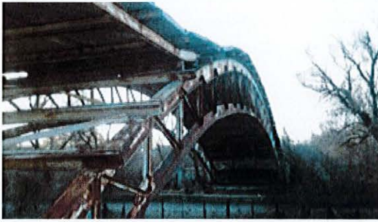
Foto 21. Vechiul pod metalic
