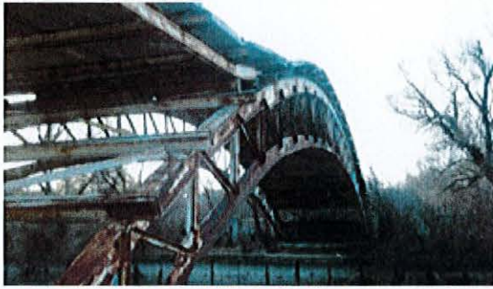
Foto 21. Vechiul pod metalic
