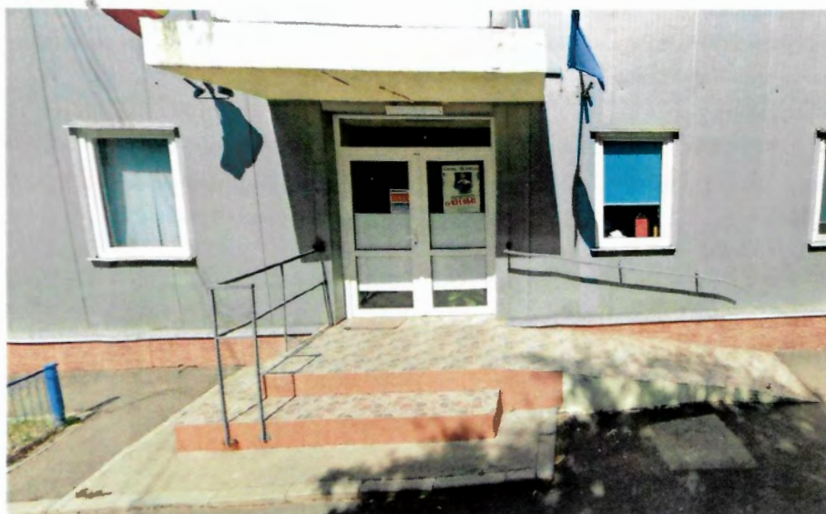
Imagine cu intrarea principală, arătând rampa și pachetul de trepte neconforme
