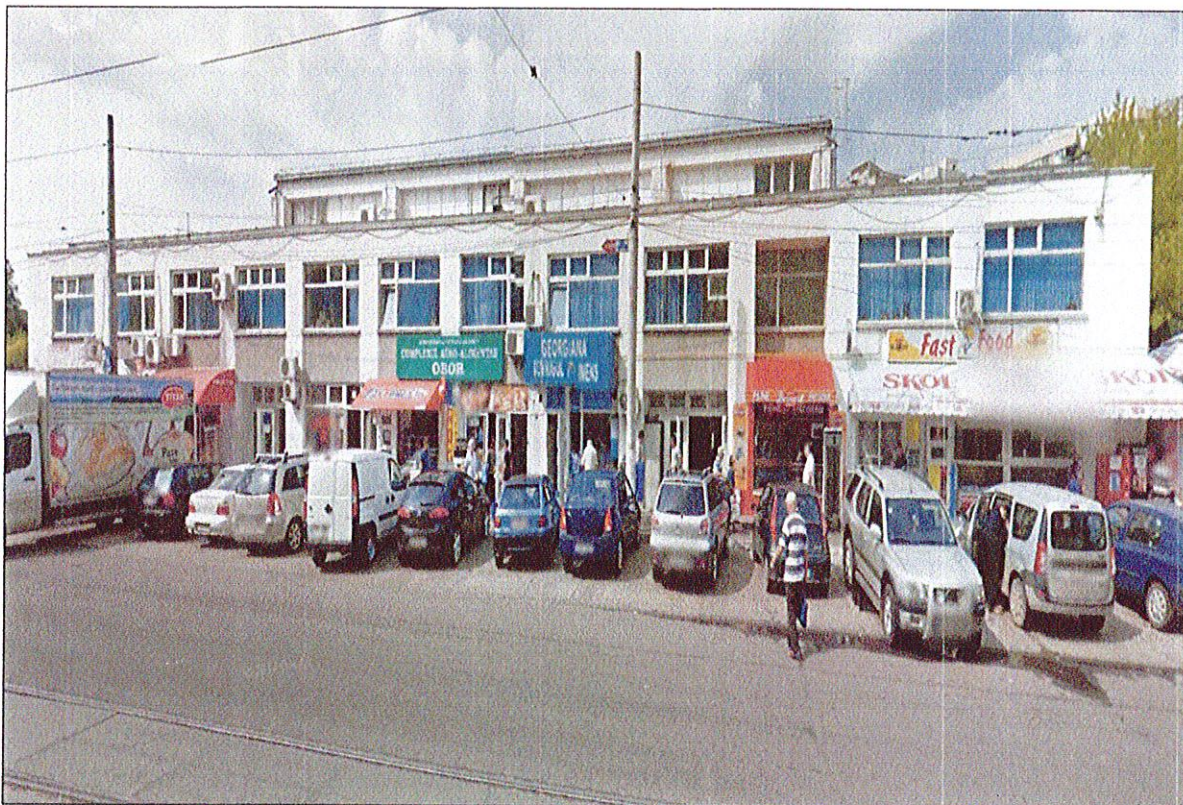
BUCURESTI, SECTOR 2, STR. ZIDURI MOSI, NR. 4
