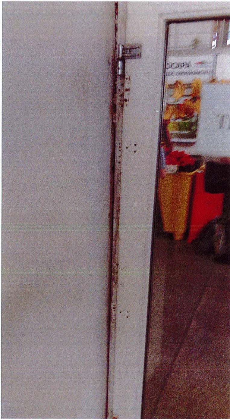
Poza usa acces – se poate observa lipsa balamalelor si multitudinea gaurilor unde au fost montate/ mutate balamalele
