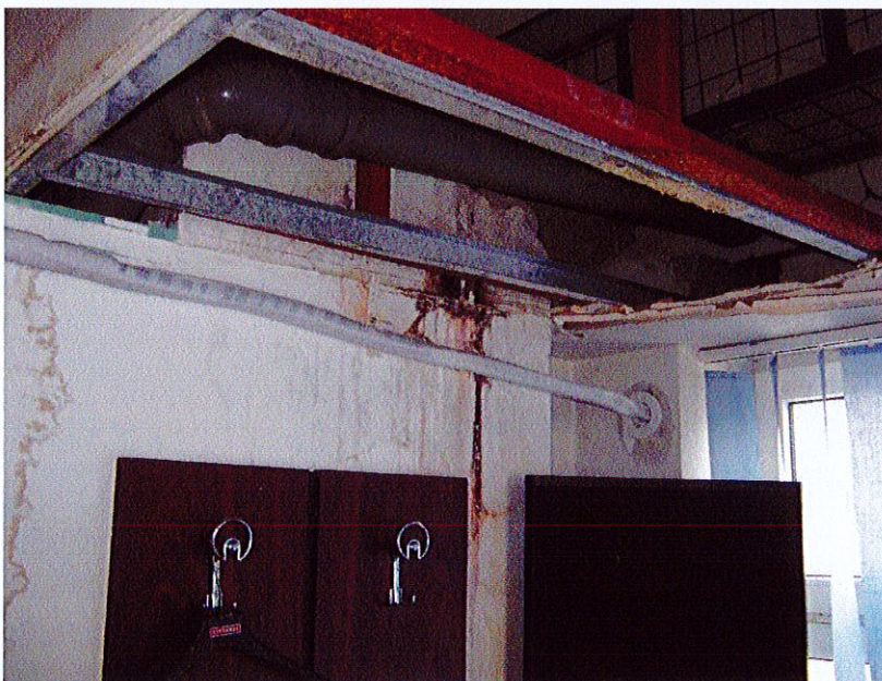
Poza mezanin – se poat observa infiltratiile pe elementele verticale si orizontale si lipa partiala a tavanului suspendat.
