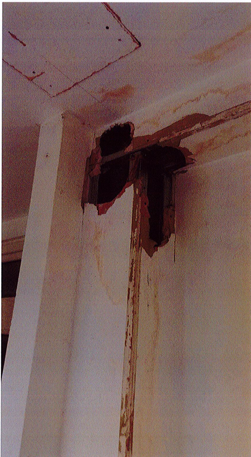
Poza interior – se pot observa deteriorari ale ghenelor
